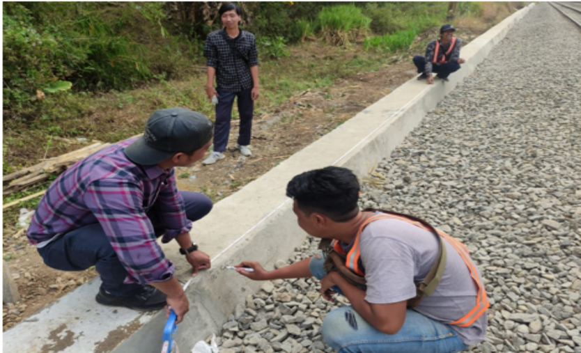
Pengukuran dan Pemeriksaan Hasil Pekerjaan Box Culvert BH 1149
