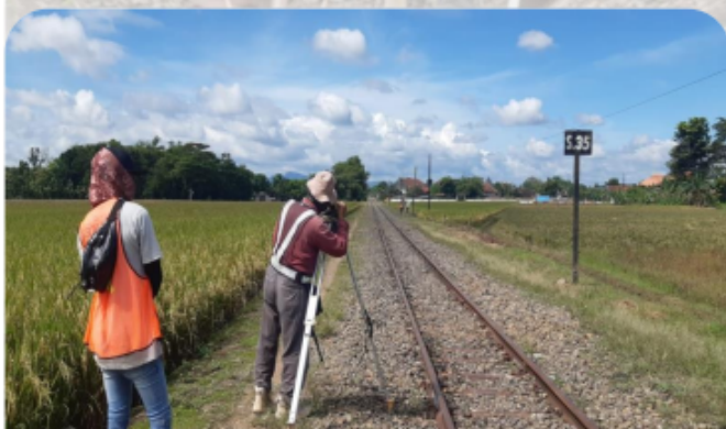
Pengukuran cros section km. 10+000
