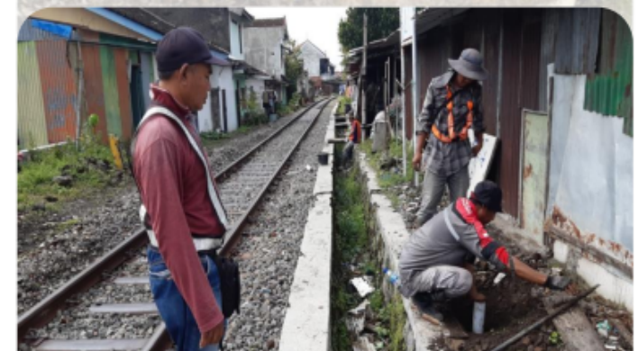
Pemasanga Patok CP Dilintas dan Patok BM di Area Emplasemen Solokota dan Sukoharjo
