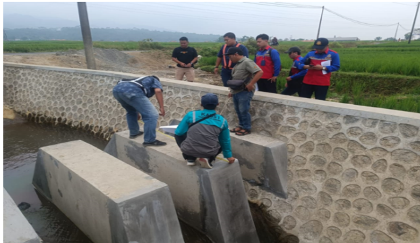
Pemeriksaan dan Pengukuran Hasil Pekerjaan Saluran Terbuka BH 1313
