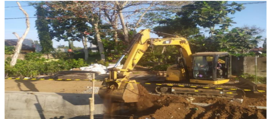
Pek. Granural Back Fill dan Urugan Tanah
