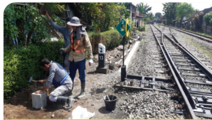
Pasang patok BM km. 13+200 Emplasemen Stasiun Sukoharjo
