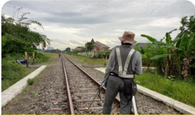
Pengukuran Cross section km. 10+000 s.d 13+000
