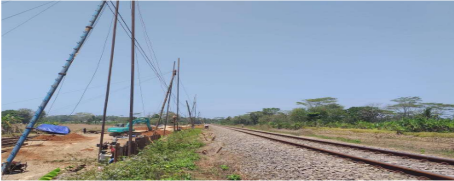
Pek. Pancang Sheetpile Baja
