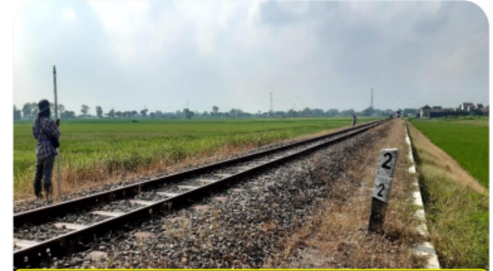
Pengukuran long section km. 2+000 sd 3+000
